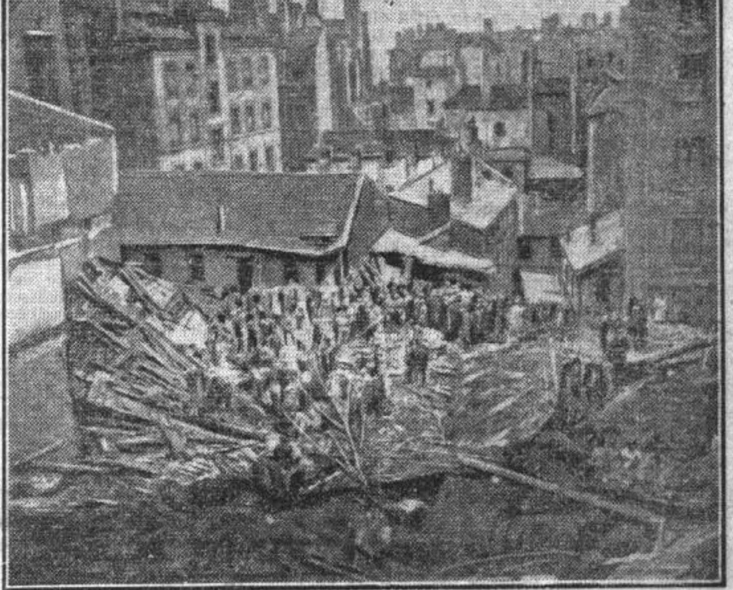
Vue d'ensemble des lieux du sinistre
