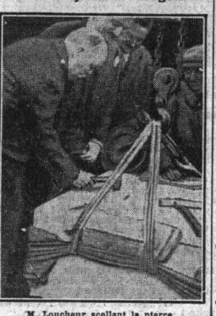
M. Loucheur scellant la pierre
