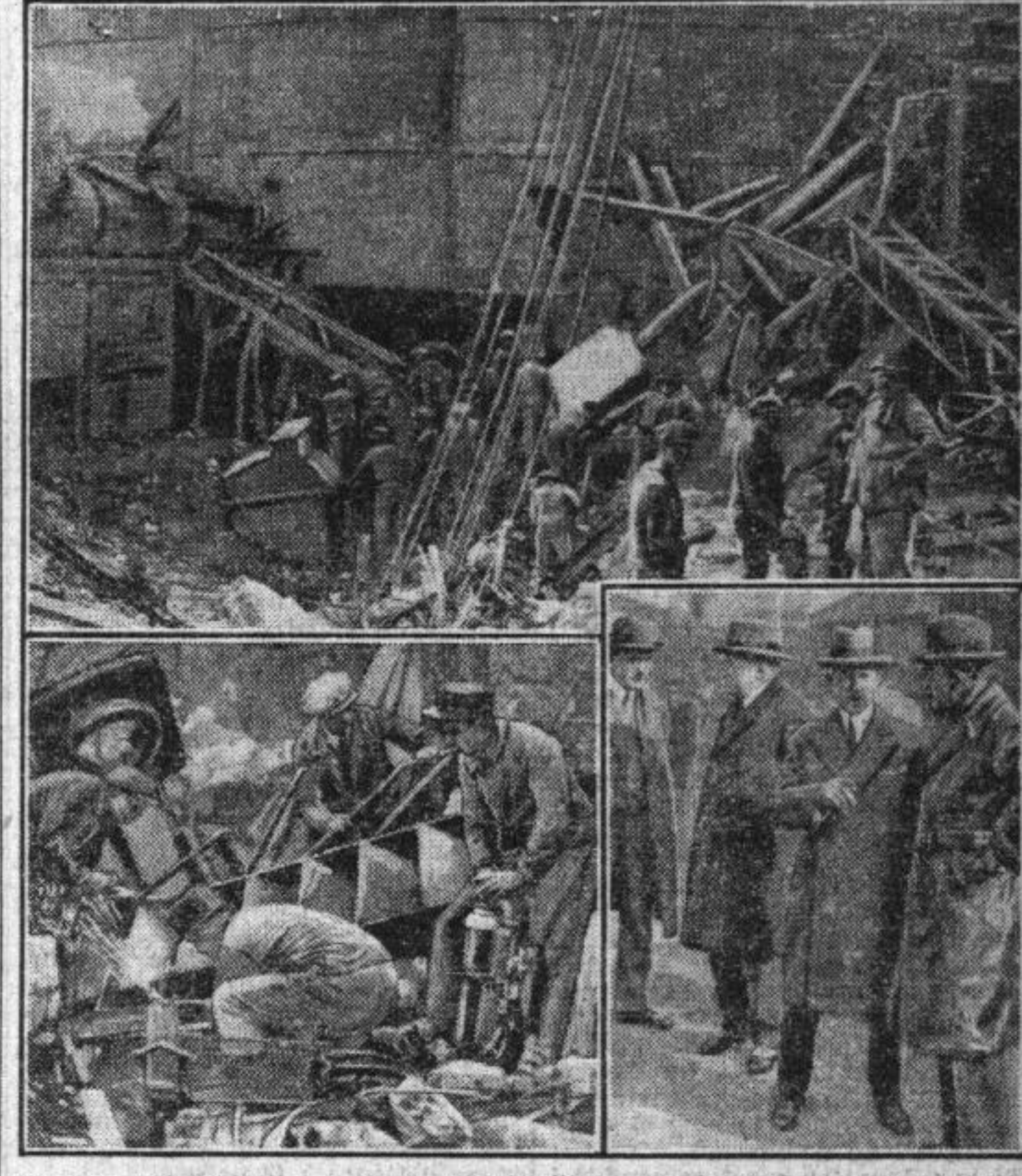
En haut : vue d'ensemble ; à gauche : la chaudière. — En bas, à gauche : pour débiter, on est forcé de recourir au chalumeau. Puis, de gauche à droite : MM. Lecourt, substitut ; Bresson, juge d'instruction ; Pressard, procureur de la République ; et Gaud, commissaire divisionnaire
