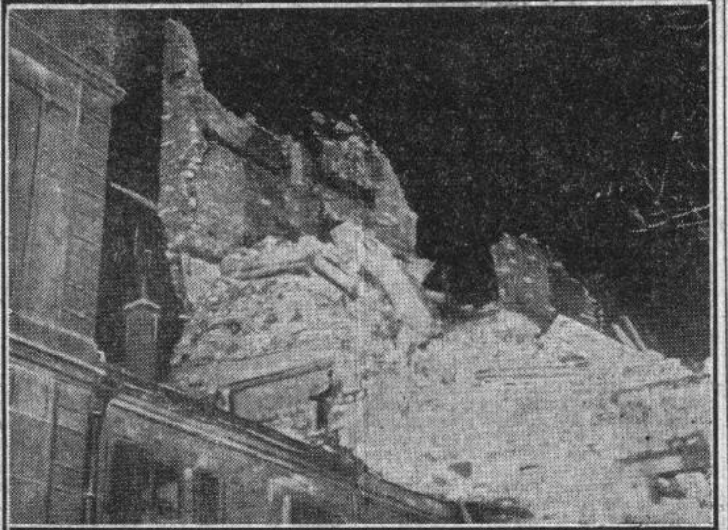
En haut : la façade effondrée sur la rue Quentin-Bauchart. En bas : une rue prise d'une cour de la rue Lincoln.
