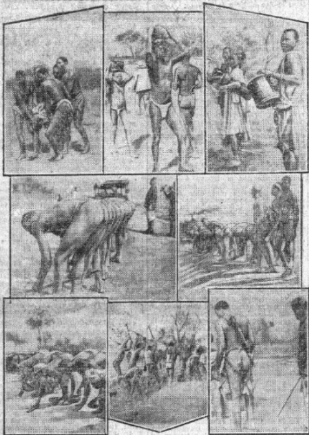
LE TRAVAIL SUR LES ROUTES. — 1 re rangée : moines primitifs de transport de matériaux (1 re et 2 e photographies). Troupe de tam-tam distrayant et encourageant les travailleurs. — Deuxième rangée : des noirs battent la route avec leurs latès. — Troisième rangée, à gauche : femmes noires occupées à la même besogne. — Au centre : des noirs défoncent le terrain à coups de pio. — A droite : le capitaine surveille les travailleurs.
