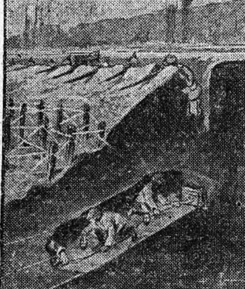
LES SAPEURS ACHÈVANT DE PRÉPARER UN FOURNEAU DE MINES
