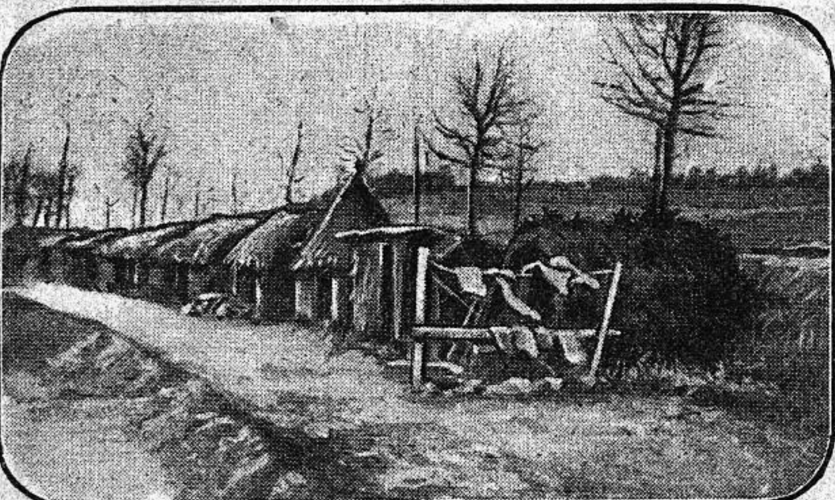
En bordure du talus d'une route de la Somme, un véritable village de cahutes a surgi soudain, dû à l'ingéniosité de nos cavaliers.
