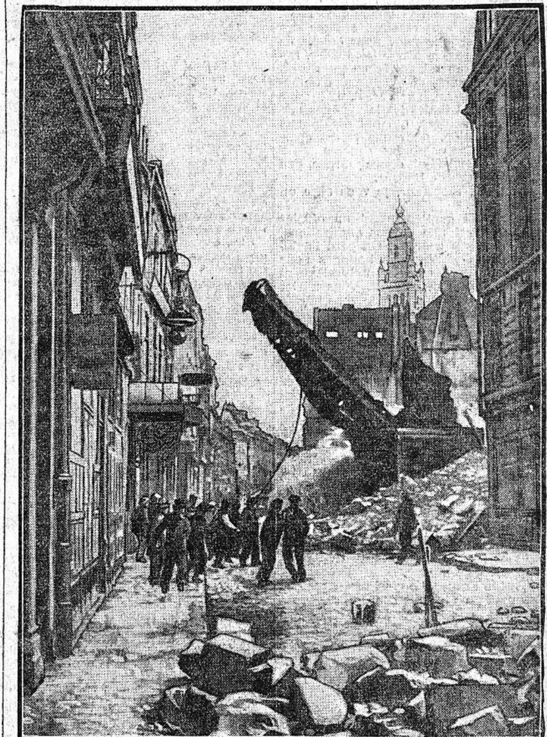
D'après l'illustration italienne. Dans une rue de Lille, on abat une maison bombardée, dont les murs seuls restaient debout.
