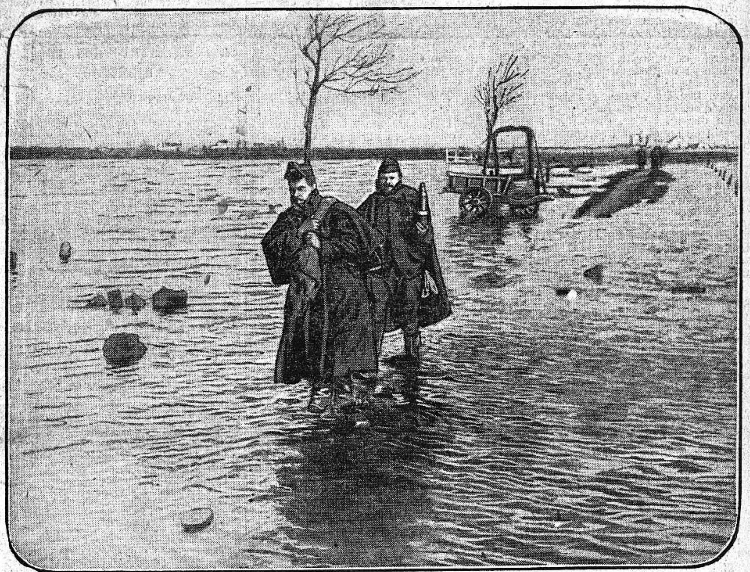
Dans leur lutte inexorable contre l'Allemand, sur les rives de l'Yser, les alliés, aux canons de 75, aux poitrines de leurs soldats, ont adjoint un moyen de défense terrible : l'inondation. Les digues protectrices démolies à coups d'obus, l'eau s'est immédiatement répandue dans les plaines immenses, obligeant l'ennemi à se retirer précipitamment, en abandonnant de nombreuses pièces d'artillerie. Notre document donne une idée saisissante de la majesté tragique de ces plaines, où la bise de novembre souffle sans répit. Des soldats belges s'efforcent de rejoindre leur poste en suivant une étroite jetée de terre. Phot. Matin.
