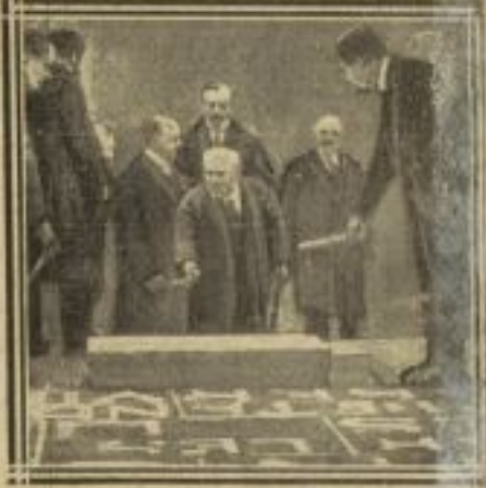
M. POINCARÉ SCELLANT LA DALLE
