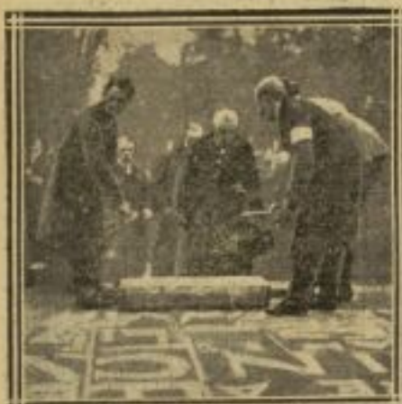
M. MILLERAND SCELLANT LA DALLE
